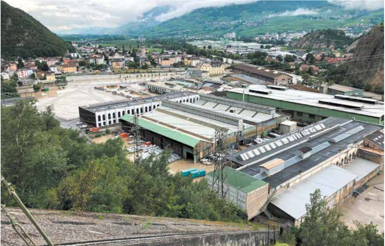
Vue d'ensemble des inondations du site industriel de Chippis le 30 juin 2024 avec, à droite, la centrale des FMV, au milieu, les hangars de stockage de Constellium, et à l'arrière, la centrale des FMG (avec les fenêtres arrondies).
